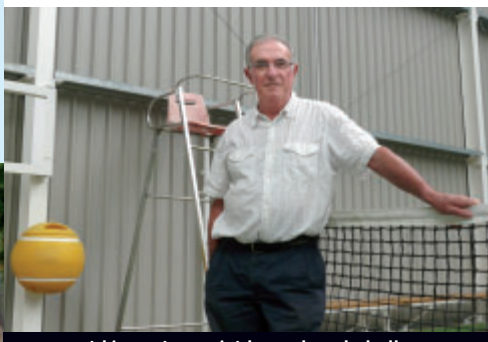
Guy Boidé, ancien président, dans la halle de tennis dont le bardage a été nettoyé et la charpente métallique repeinte.
